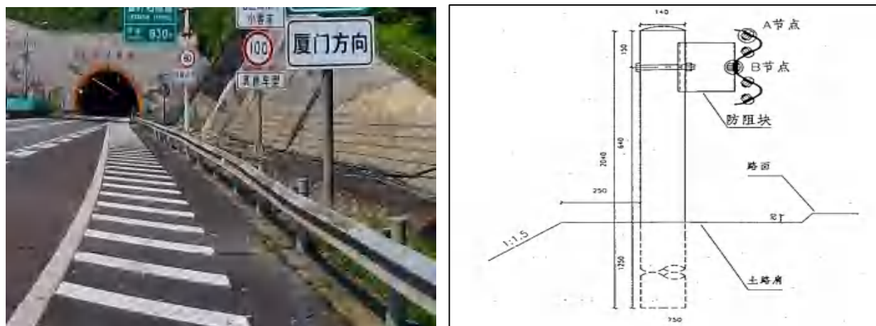
图3-1 K2076+319~K2100+322段路侧钢护栏现状
