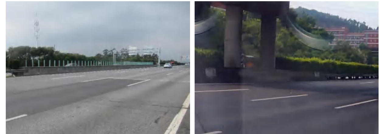
图3-8 沈海高速公路福泉段闽华 I 型护栏现状
